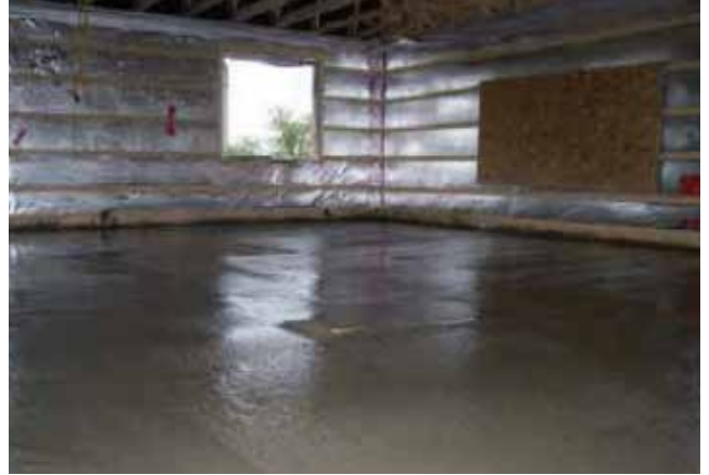
Thermason VB après la coulée de béton Thermason VB after concrete pour
