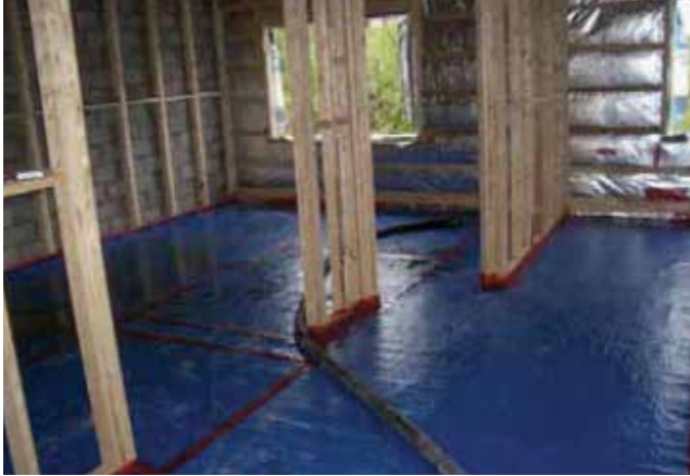
Thermason VB avant la coulée de béton Thermason VB before concrete pour
